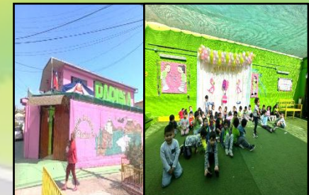
- Instalación de Malla ,pintura de fachadas, pintura de salas y patio.
