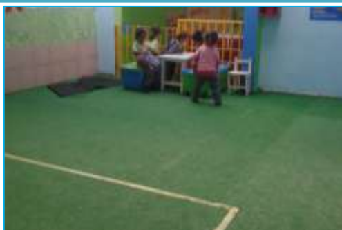
Reparación de sillas, mesas y pintura en las paredes exteriores: patios. Cambio piso nuevo de sala n° 3, colocación de pasto sintético en patio 1
