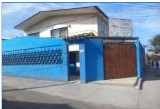
Pavimentación del costado y entrada de la Escuela Parina.
