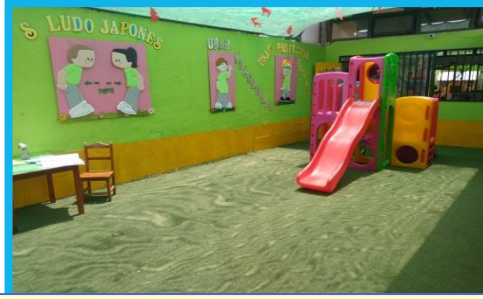
Colocación de malla para patio, cambio de pasto sintético y pintura de patio sala 5.
