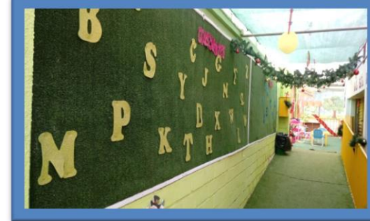
Se coloca pasto sintético en muralla y pasillo de ingreso a la escuela
