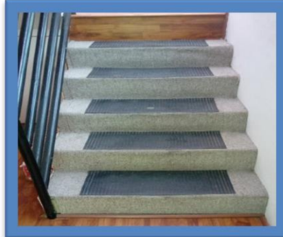
Se coloca alfombra y goma a la escalera que llega a Secretaria.
