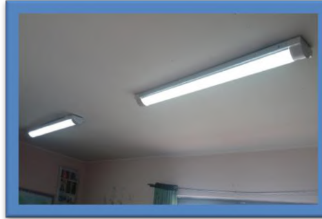
Se realiza el cambio de luminaria en sala de profesores y sala N° 1
