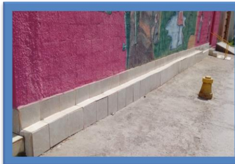
Se coloca cerámica por fuera de la escuela
