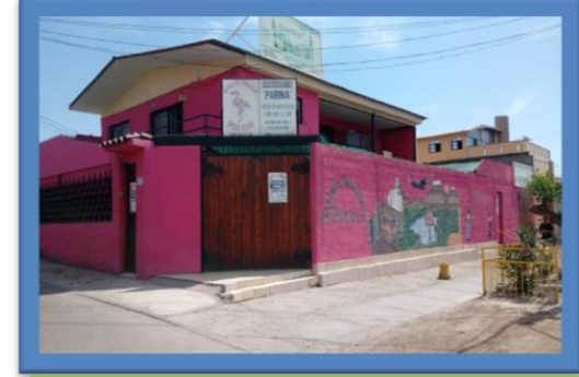
Pintura exterior de la escuela
