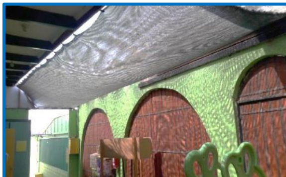
Colocación de malla para el patio n°3
