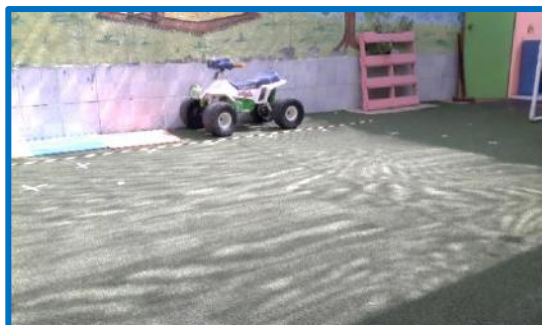
Colocación de pasto sintético patio n°3
