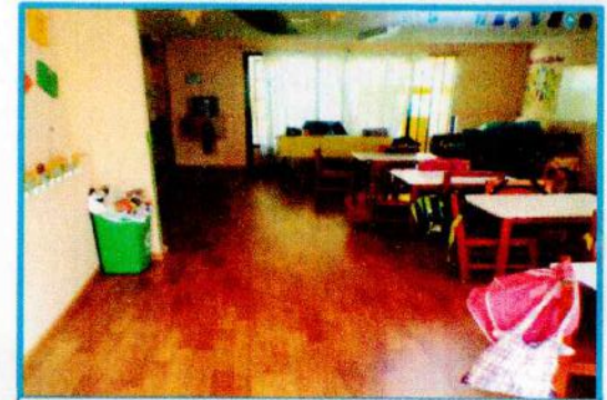
Colocación de pisos flotantes en dos salas.
