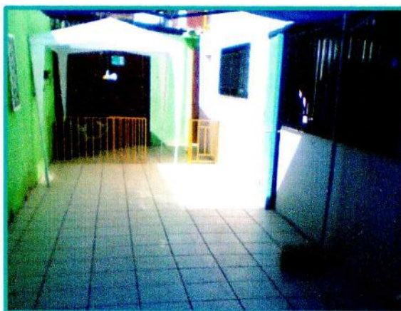
Colocación de cerámica en la parte lateral del patio.
